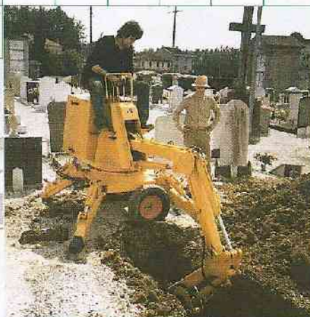
▲ Scavi per tombe nei cimiteri Friedhofsarbeiten Cemetery excavations Creusements dans les cimetières
